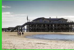
Pfahlbauten St. Peter Ording
